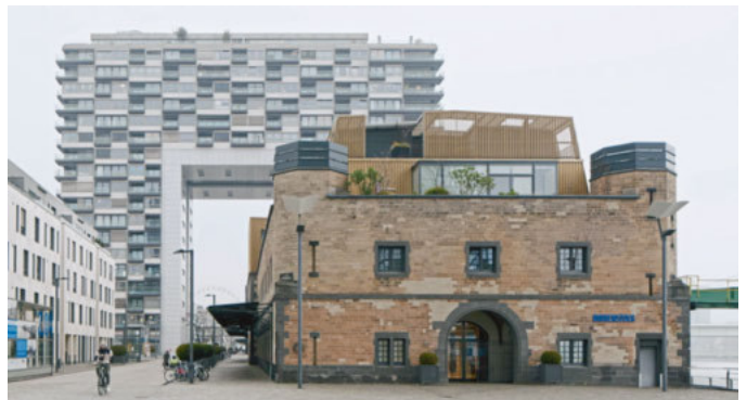
Außenansicht des kernsanierten Loft on Top auf dem alten Speicher am ehemaligen Rheinauhafen in Köln-Süd
