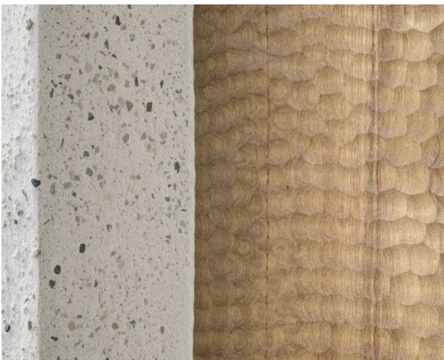
Markantes Werkstoffduo: Die Türleibung in gewaschenem Grobputz aus lokalen Sanden und Weißzement fasst das von einem Holzschnitzer behauene Ulmenholzportal ein
