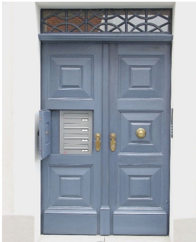
Betreutes Wohnen mit mehreren Einheiten in altem Fachwerkhaus
