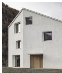
Das Haus als Solitär behauptet sich in der Klarheit der traditionellen Südtiroler Herrenhäuser im Schatten der umgebenden Bergkulisse
