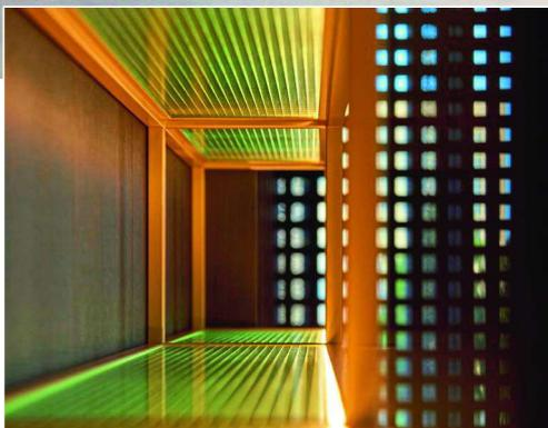
**Lichtobjekt und abgehängter Stauraum: Oberhalb der Kücheninsel schwebt ein Korpus aus Vierkantrrohr und Streckmetall. Die Böden in Drahtglas sind von Firma Niggemann aus Münster mit Wasserstrahl geschnitten**
